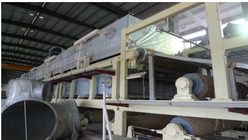
图1：广东金叶2期生产线组建中
